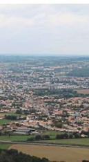
Projet d'aménagement et de développement durable (PADD). C'est un document simple et concis qui doit donner une information claire aux citoyens et habitants sur le projet territorial.
