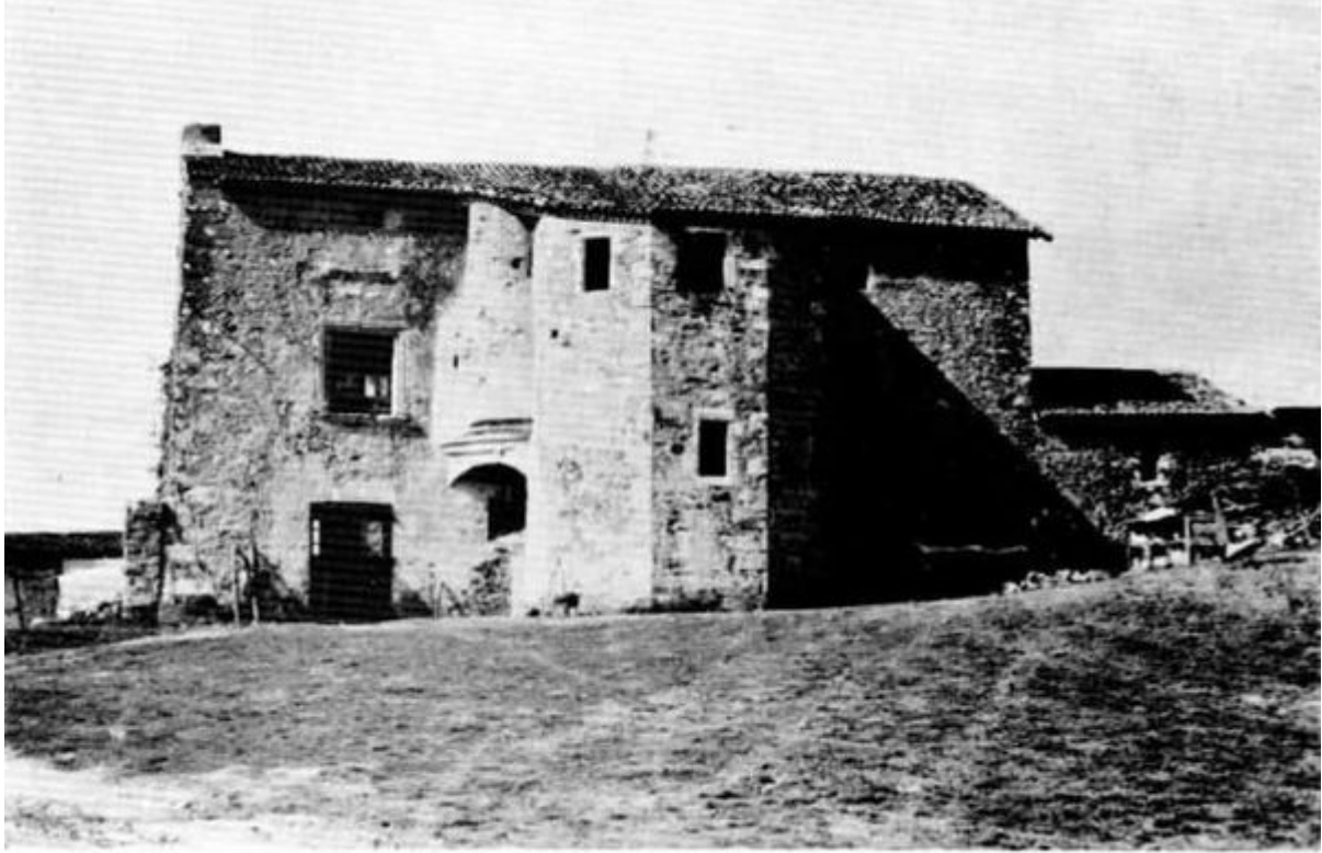
SAINT-PAUL-EN-PAREDS, LES NOYERS. Façade sud-est.
